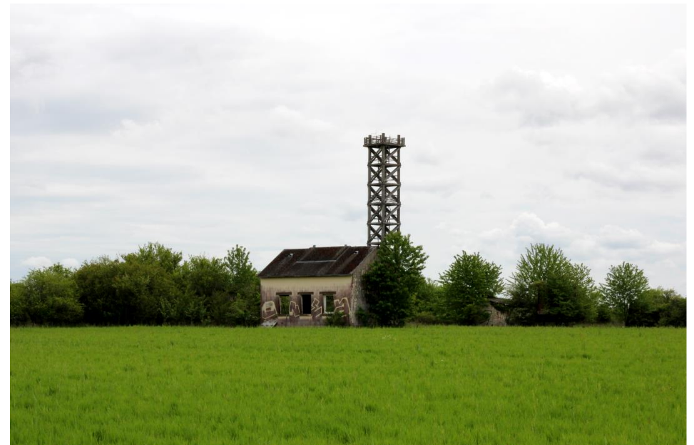
Photo 2 : Les constructions de l'ancien Centre de Recherche Géophysiques de Garchy sont encore visibles
